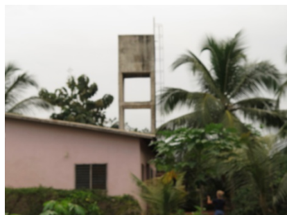
Le chateau d'eau et la salle de formation
