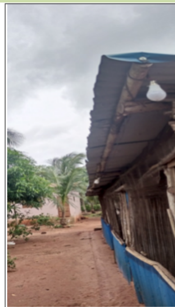
Vue du poulailler avec des lampes solaires
