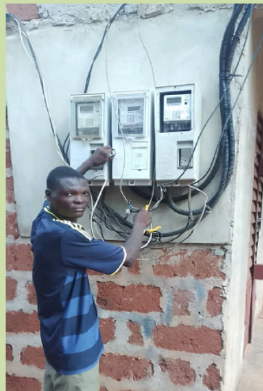
Hyacinthe au cours d'un câblage
