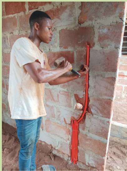
Médard au cours d'une installation encastrée
